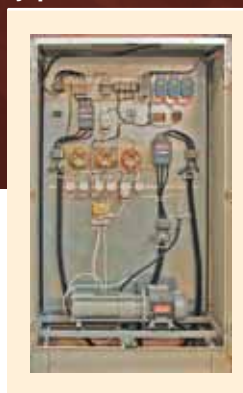
Рис. 9. Расположение элементов в блоке управления БУ-НМ
